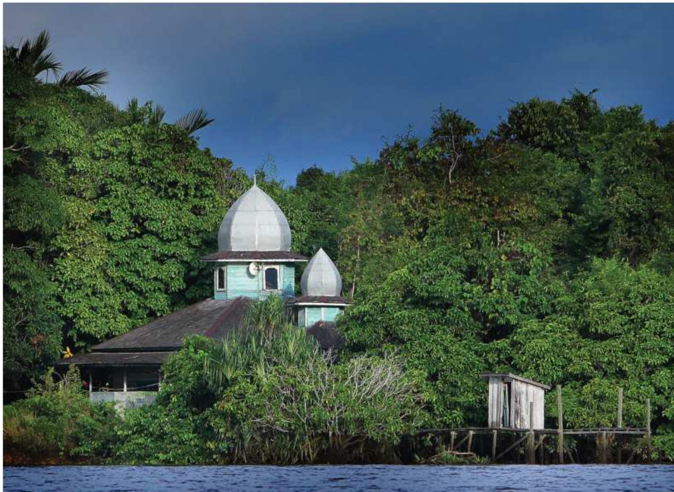
Bangunan Pabrik, rumah dan mushola berada di bantaran sungai Barito menjadi saksi peradaban dan jejak arsitektur Banjar (foto 2010)
